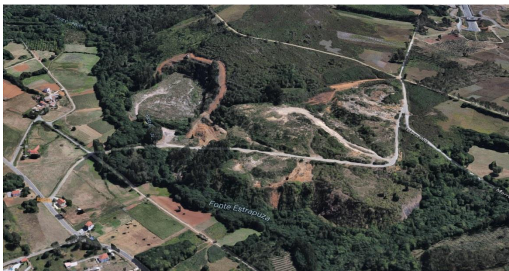
Zona del antiguo vertedero de Aríns, prevista para su restauración ecológica. Fuente: Google Earth.
