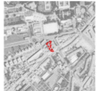
10. Edif. Av. Barcelona
