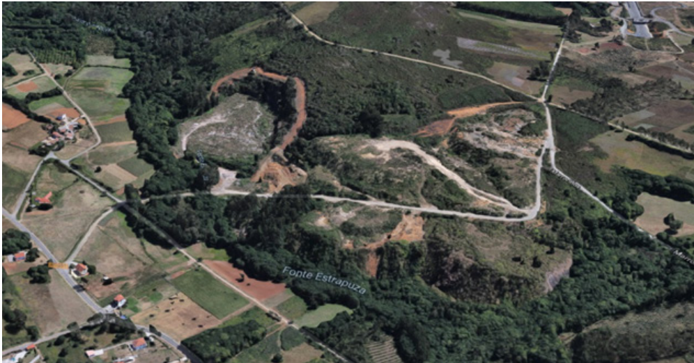
Zona do antigo vertedoiro de Aríns previsto para a súa restauración ecolóxica. Fonte: Google Earth.
